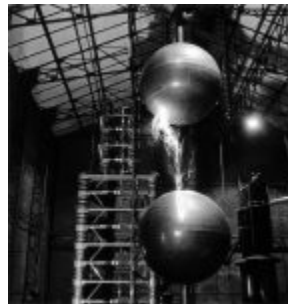
Fig.1 : L'éclateur du générateur d'impulsion au laboratoire de synthèse atomique d'Ivry, 1942-1943.
